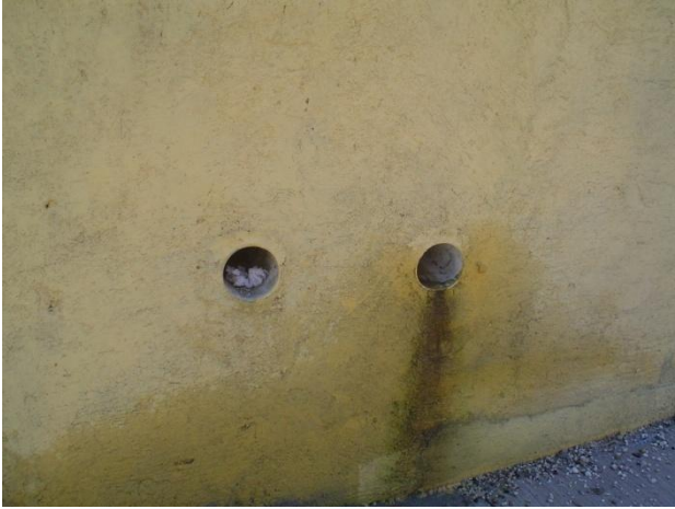
Drenajes del muro de contención del salón
