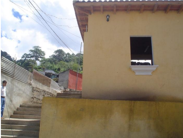
Gradas de acceso al salón municipal
