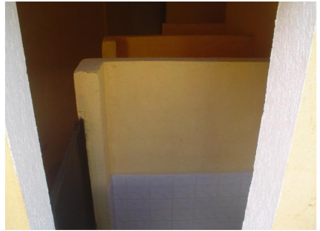
Sanitarios del salón municipal
