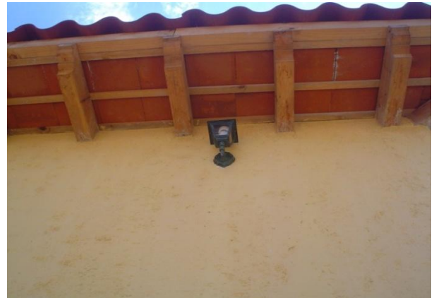
Voladizo exterior del salón municipal
